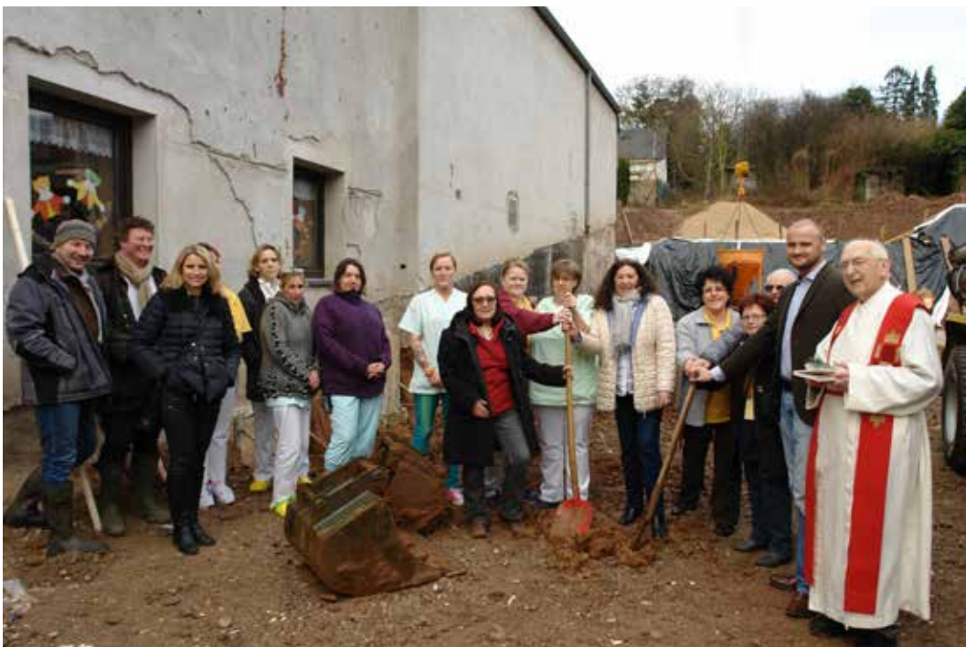
Bei nasskaltem Wetter nahmen Frau Berger-Neffgen und Herr Wiegand die Schaufel zur Hand und setzten den „Spatenstich“. Damit läuteten Sie eine aufregende und spannende Zeit der Veränderung ein.
